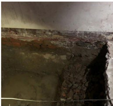
▼ 图四 埋深及浅的基础悬挑梁
