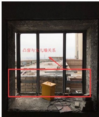
▼ 铝窗设计高度与檐口装饰线条冲突，影响效果
